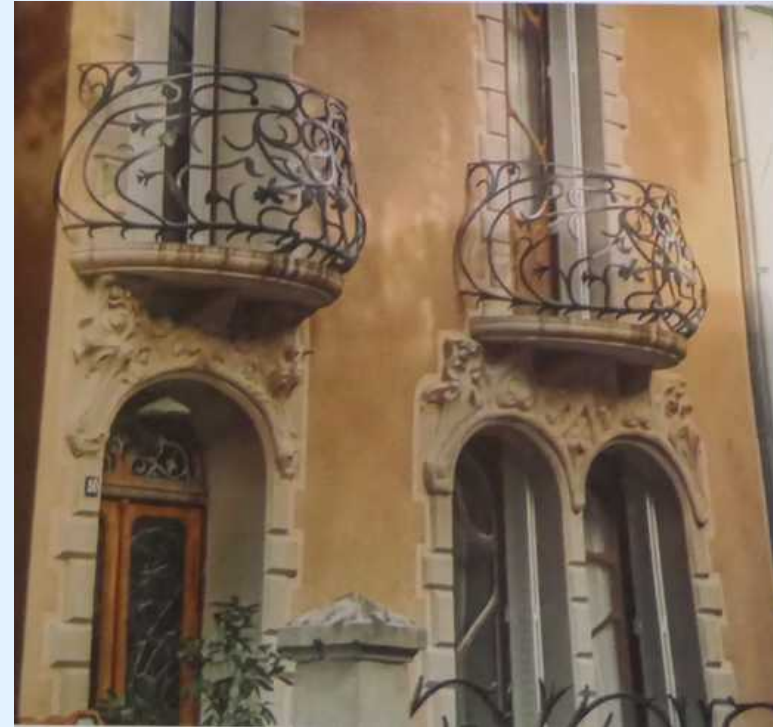
Détail de la façade art nouveau de la villa Liberty
