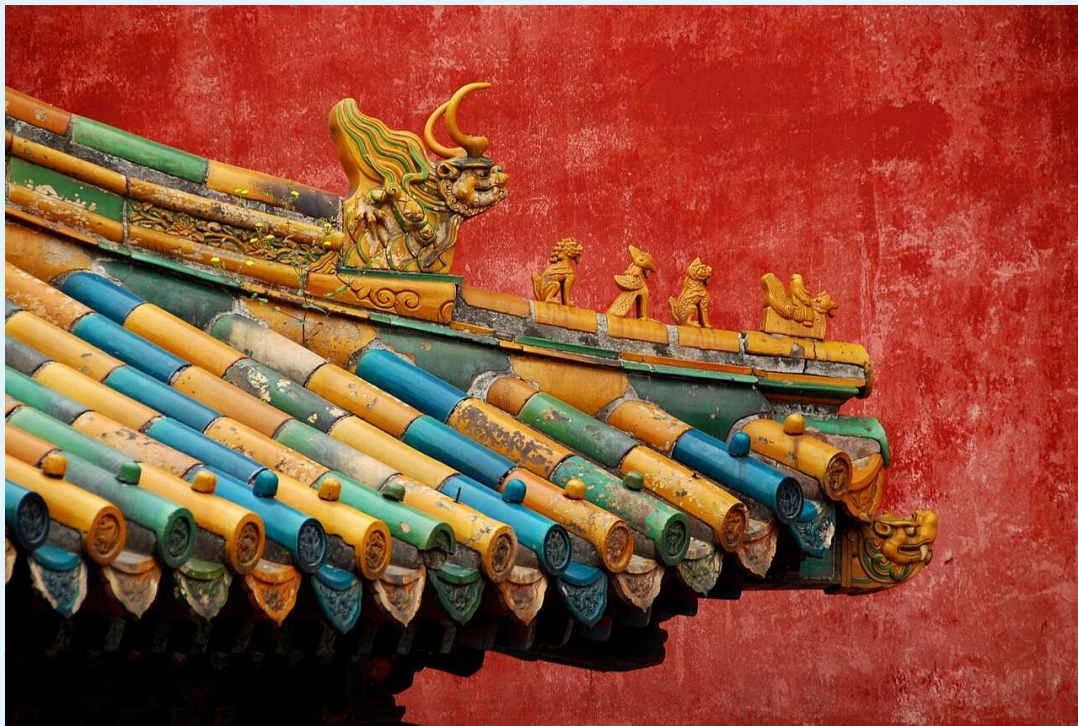
Détail des couleurs d'un toit et d'un mur refait en 2008.
